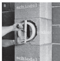
8 Mit Draht Zarge am Innenrohr anpressen und ausquellenden Kitt verstreichen.
