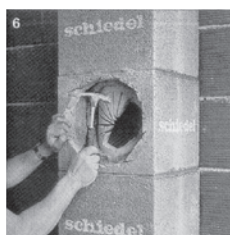
6 Schamotteteile vorsichtig entfernen.
